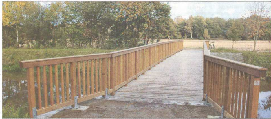
Konstruktiver Holzschutz und die Verwendung von Lärchen-Kernholz lassen dauerhafte Konstruktionen in der Gebrauchsklasse GK 3 zu. Foto: Müller
